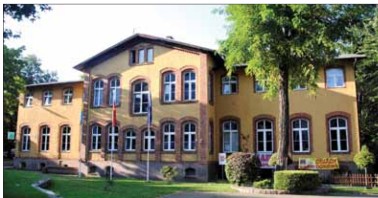
Budynek Ośrodka Kultury Związku Ukraińców w Szczecinie (fot. Leszek Wątróbski)
