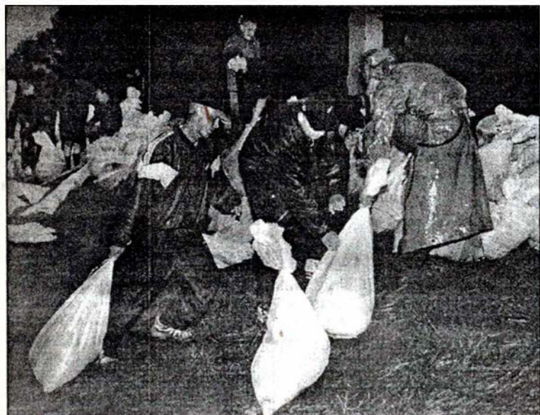
Kolejna noc minęła mieszkańcom Słubic i służbom przeciwpowodziowym na patrolowaniu wałów i uzupełnianiu ich w miejscach, w których przeciekały
