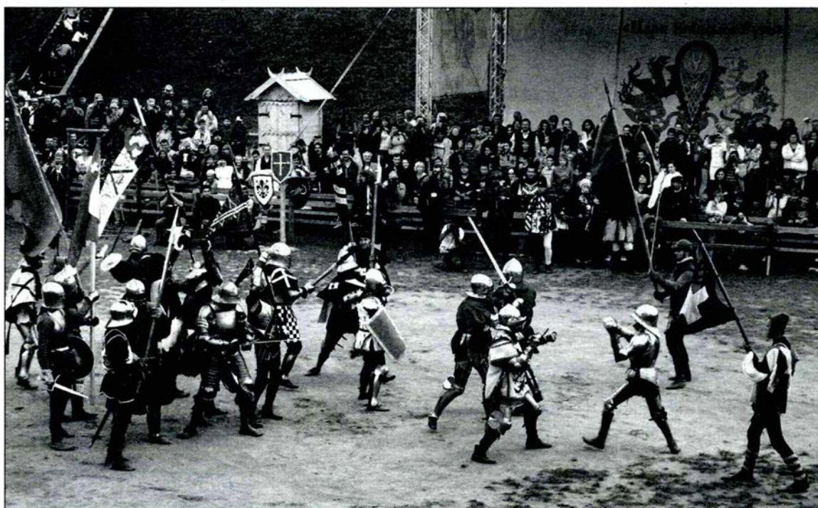
Szczek oręża, rzenie koni i oklaski widzów zafascynowanych niecodziennym widowiskiem rozlegał się nieopodal podkijowskiej wsi Kowaczów na terenie „Parku Kijowska Ruś” – patrz str. 2
