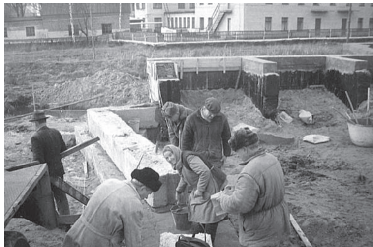
Budowa świątyni w Dowbyszu
