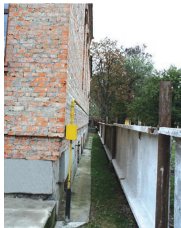
Szkaradny żelazo-betonowy mur ustawiony w niewytłumaczalnie małej odległości od budowli świątyni - świadectwo żąłostnej pychy jego zleceniodawcy
