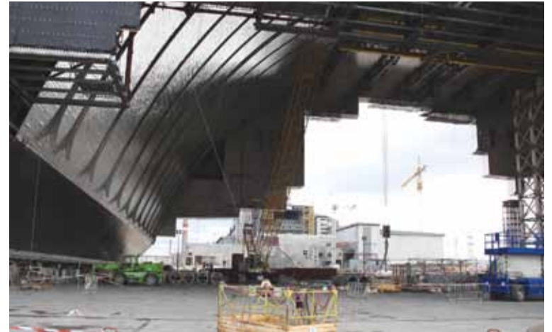
Ostona - ogromna konstrukcja (108 m wysokości i powierzchni niemal 2-ch boisk futb.), w której na 100 lat zamknięty zostanie IV reaktor elektrowni w Czarnobylu. „Arka” będzie na niego nasuwana w tempie 10 metrów na godz.
