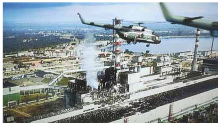
Płonący reaktor zasypywano tonami boru, dolomitu, glinu i ołowiu. Śmigłowce Mi-8 i Mi-26 latały prawie bez przerwy. Pierwszego dnia po wybuchu - ponad 100 kursów, drugiego - 300
