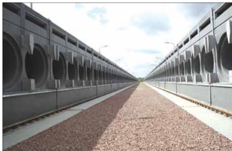
Fragment przygotowywanych 232 solidnych betonowych komór w strefie przechowywania zahermetyzowanego w kasetach paliwa jądrowego. Powinny wytrzymać trzęsienie ziemi, czy uderzenie dużego samolotu. Transport paliwa rozpocznie się w przyszłym roku i potrwa 9 lat
