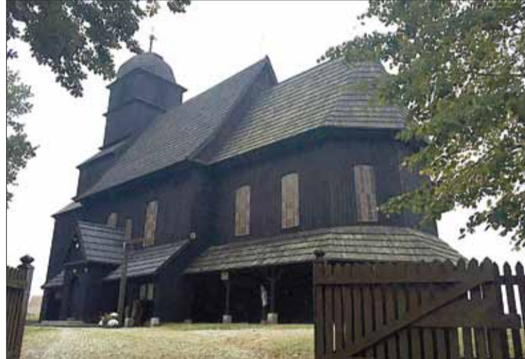
Kościół pw. św. Macieja w Trzebicku jest rzadkim już dzisiaj przykładem drewnianego budownictwa sakralnego. Powstał w 1672 r.
