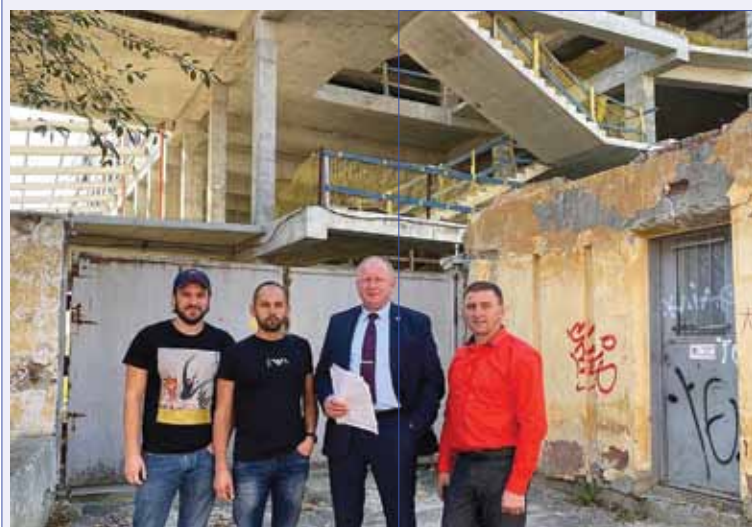
Delegacja ZPPU na placu budowlanym przyszłego Domu Polskiego we Lwowie
