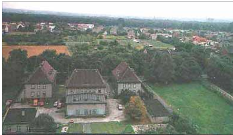
Zdjęcie budynku radiostacji w Gliwicach (Źródło: zbruc.eu https://nod40961 )
