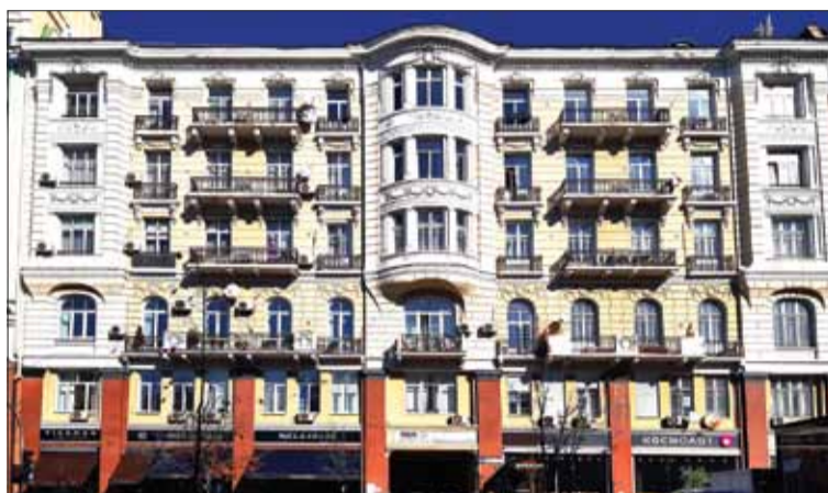
Zdjęcie domu dochodowego Kruszewskiej (ul. B. Chmielnickiego 32). Współczesny wygląd
